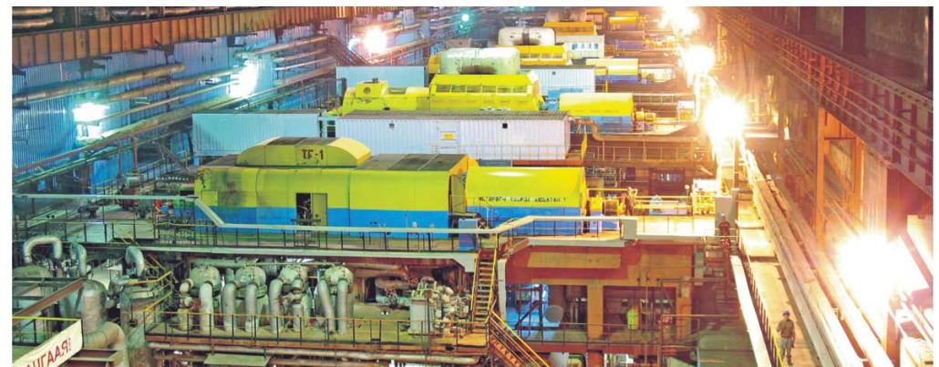
Дөрөвдүгээр цахилгаан станцын хүчин чадлыг 100 МВт эрчим хүч, 180 Гкал дулаанаар нэмэхээр ажиллаж байна. Уралын турбины үйлдвэрийн Т-120/130 маркын турбогенератор суурилуулж, 2014 оны 3-р улиралд ашиглалтад оруулна.
